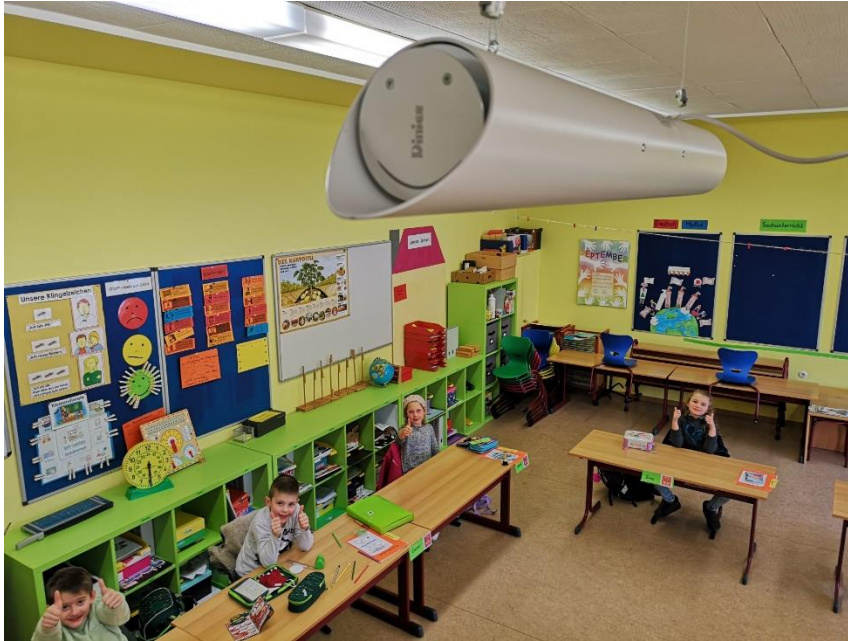
Abbildung 1 Dinies UVG80 Luftentkeimer in einem Klassenraum
